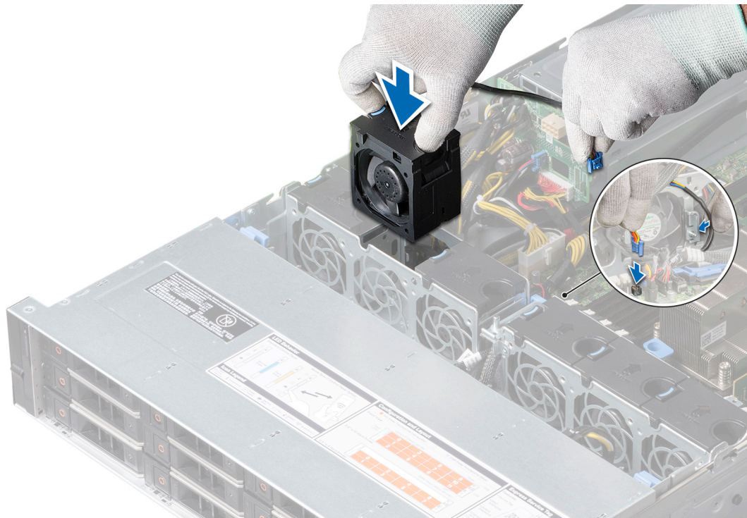
Abbildung 36. Installieren eines Kühlflüters
