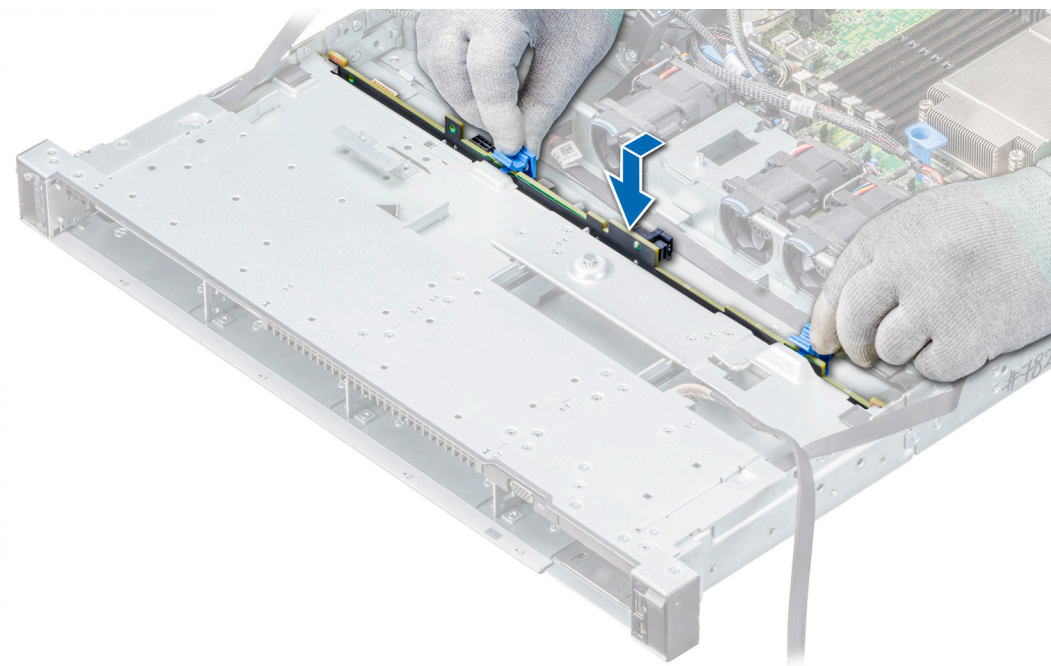
Figure 74. Installation du fond de panier
