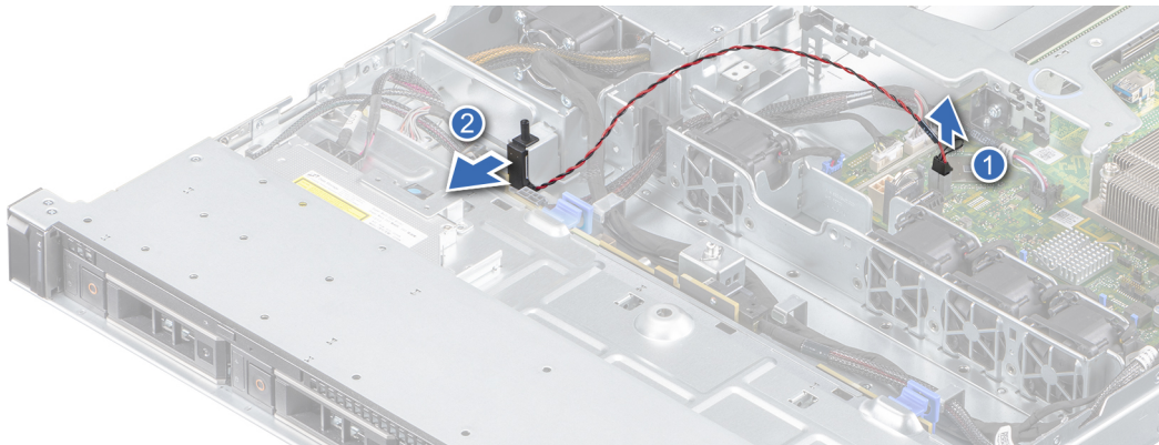
Ilustración 33. Extracción del interruptor de intrusiones
