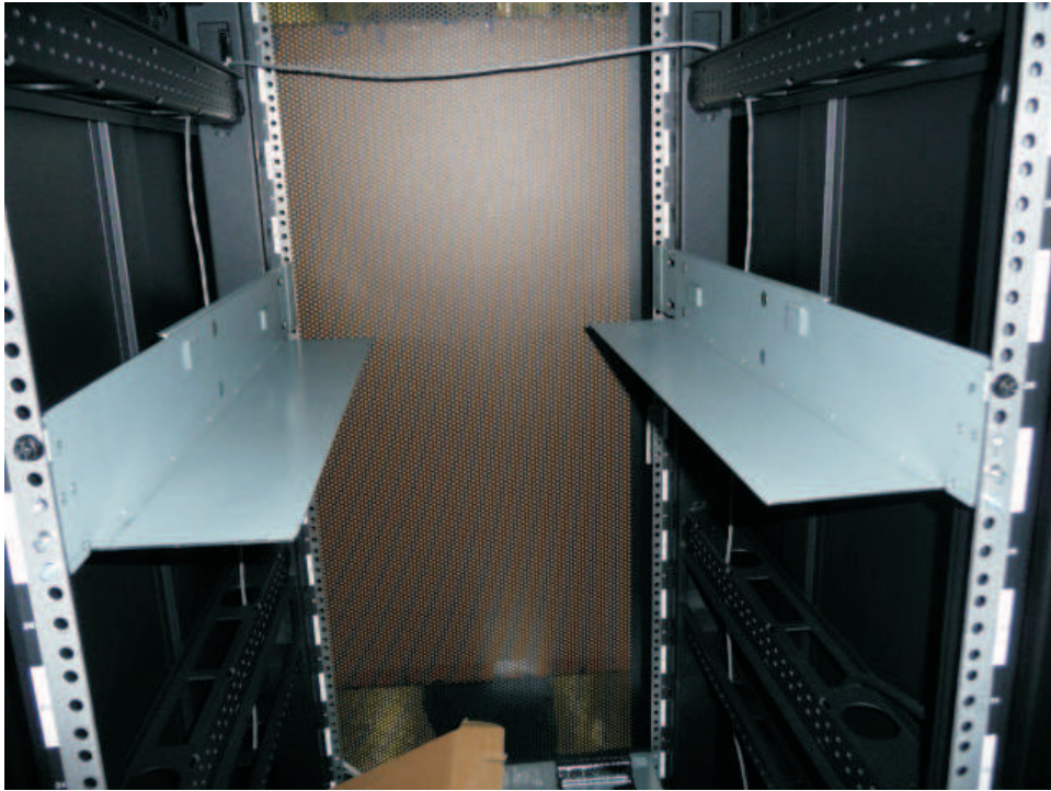
그림 29. 킷 A(원이 있는 맨 위 그림)는 설치된 레일을 보여줍니다. 아래 랙 킷 B는 이 설치된 킷의 앞면을 보여줍니다.
