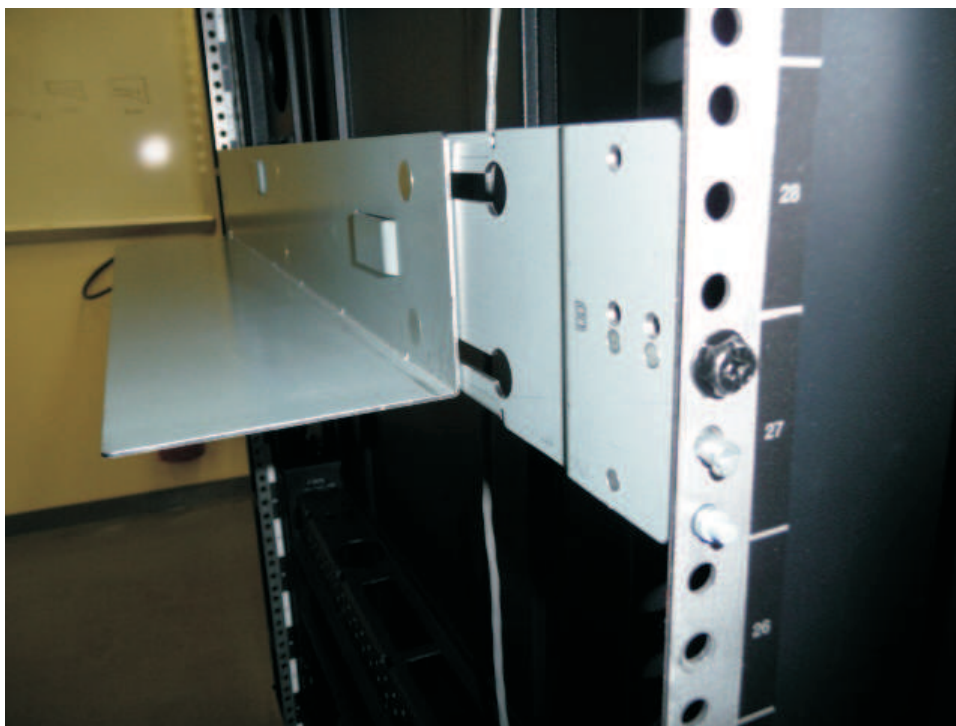
Figure 28. Vue arrière du kit de l'armoire B affichant une méthode différente de montage
