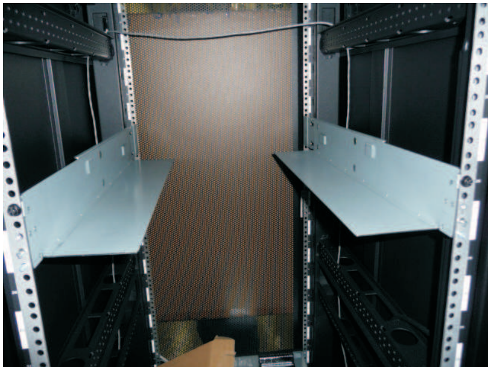
Figure 29. Kit A (image supérieure avec des cercles) affichant les rails installés. Le kit de l'armoire B affiche ci-dessous la vue de face de ce kit installé.
