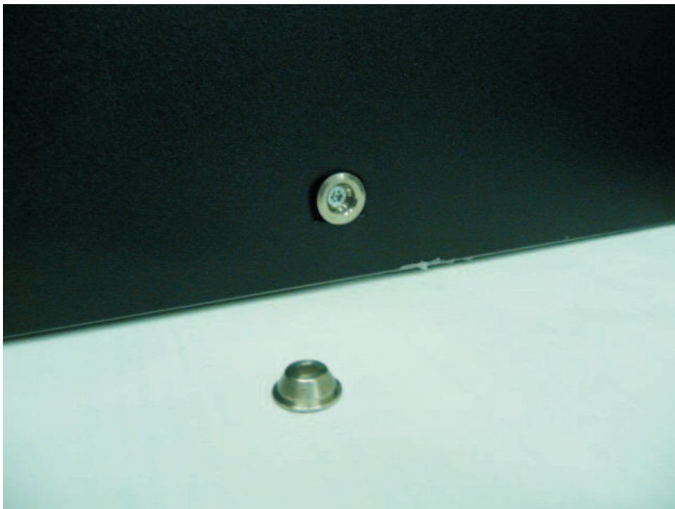
Figura 31. Vista ampliada del montaje de los anclajes en ambos lados de la biblioteca
